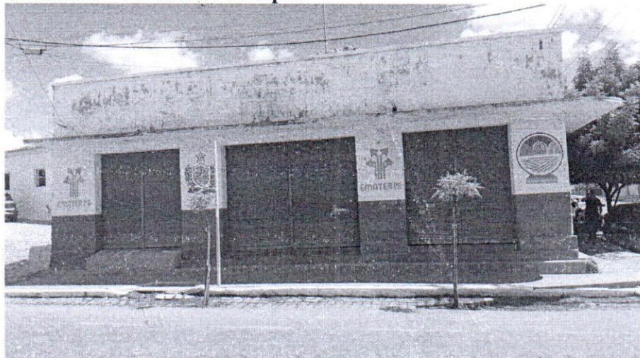
ANEXO I – Fachada Principal
